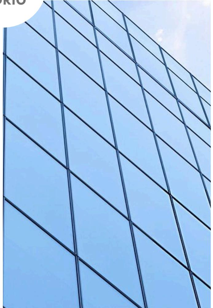
Sistema de fachada continua. Ideal para resolver fachadas comerciales. Se compone de columnas y travesaños que se unen entre sí, permitiendo realizar paños fijos y, eventualmente, ventanas desplazables.
